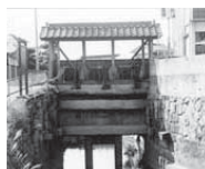
移築前の土手町南蛮樋
