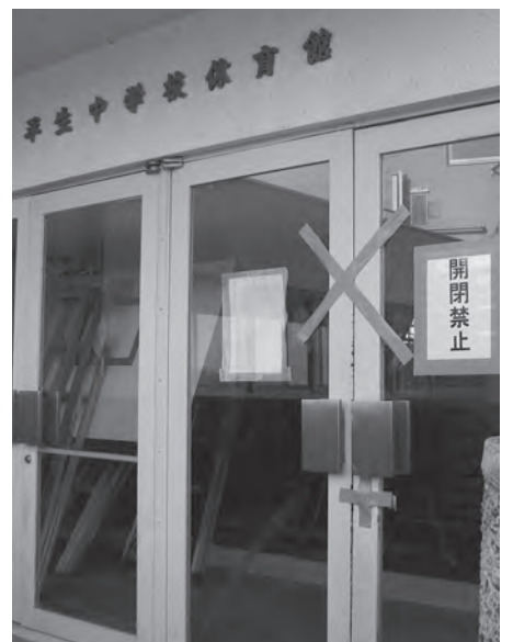
避難所となっている平生中学校体育館
