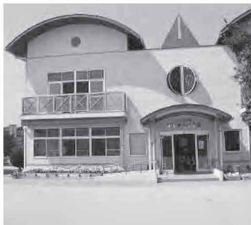
非常用発信器が設置される児童館
