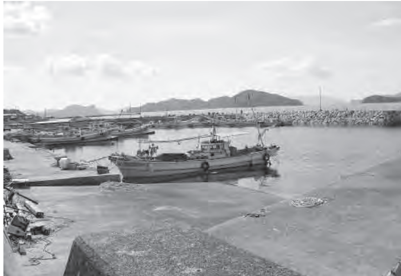
伊保木漁港の浚渫工事現場
