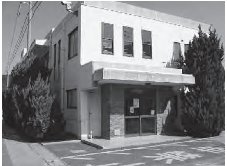
スロープがない尾国コミュニティセンター
