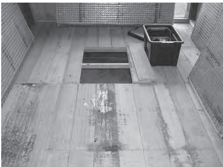
修理中の町営住宅
