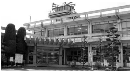
昭和35年に建設された庁舎
