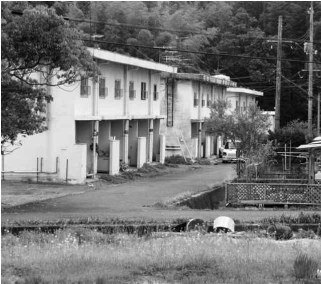
火災警報器が設置される大野中村団地
