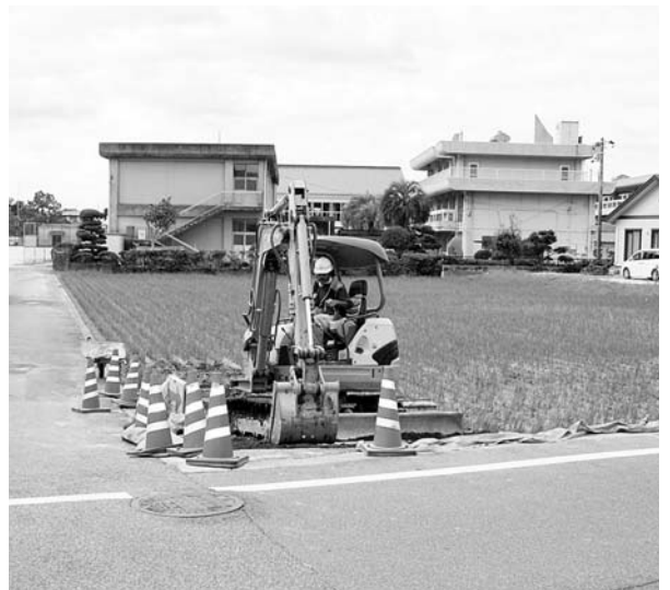
地元業者への配慮が求められる改築工事
