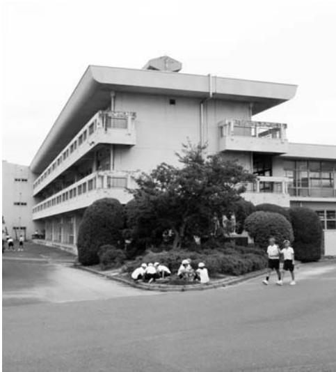
解体される教室棟
