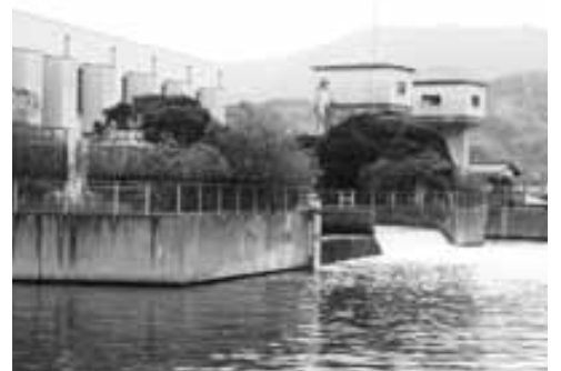
大内川排水機場
