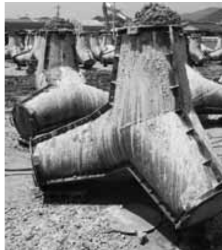
追加製作される消波ブロック
