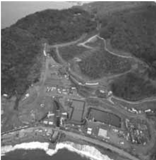
上関町原子力発電所工事現場
