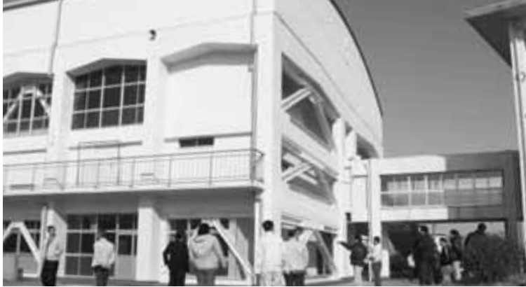
耐震補強改修が完了した平生中学校屋内運動場
