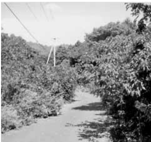
維持管理が必要な室津半島スカイライン
