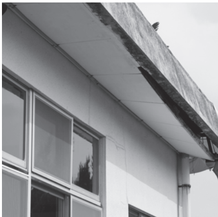
解体の決まった曾根公民館
