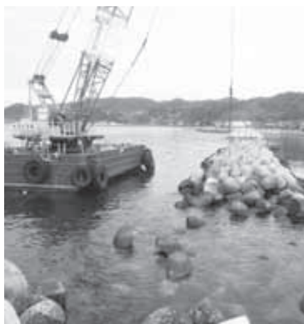
浜田沖の工事のようす
