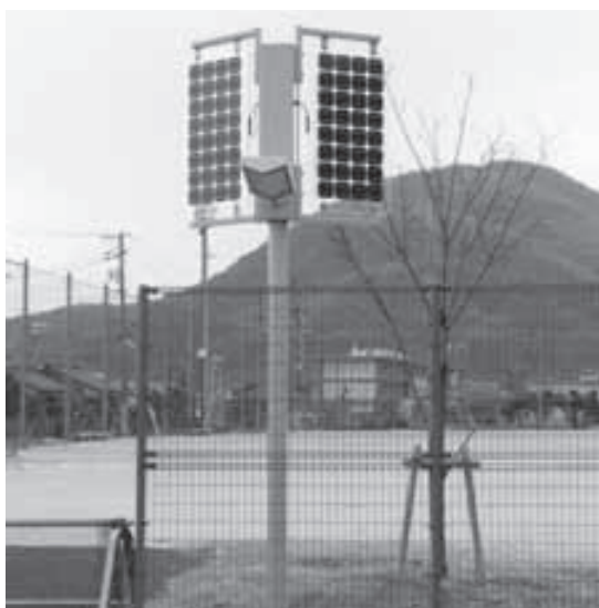
停電時にも点灯する太陽光発電LED照明灯(周防大島町久賀)
