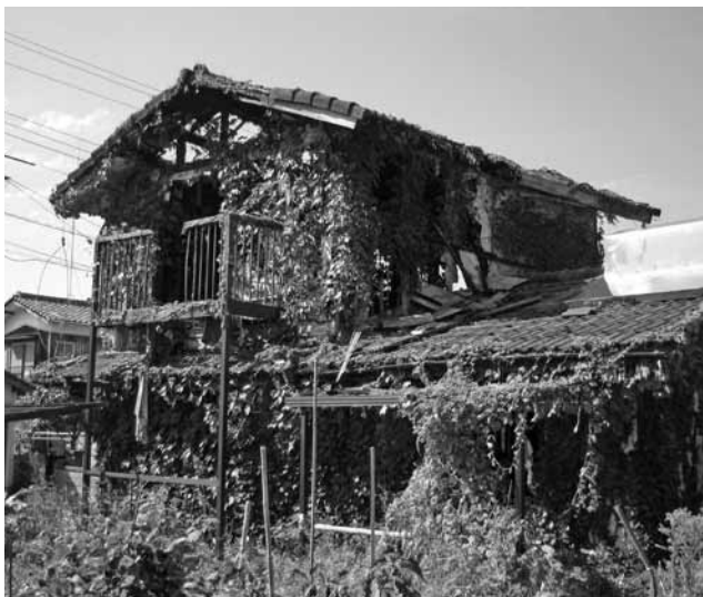
火災後に放置された家
