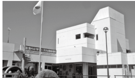
耐震診断を行う中央公民館
