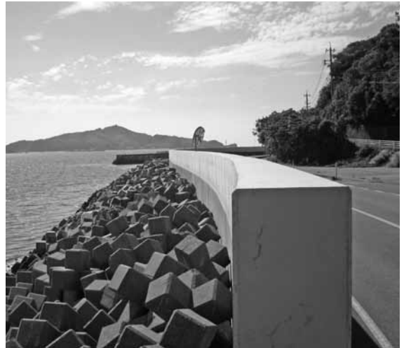
消波ブロックと防潮壁 (名切地区)
