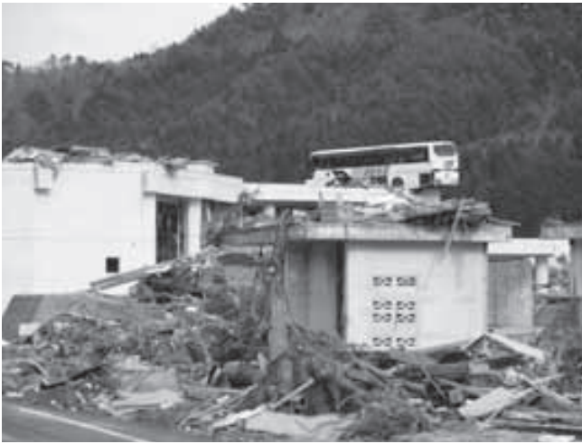
震災の被害状況
