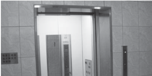
エレベーター保守点検
