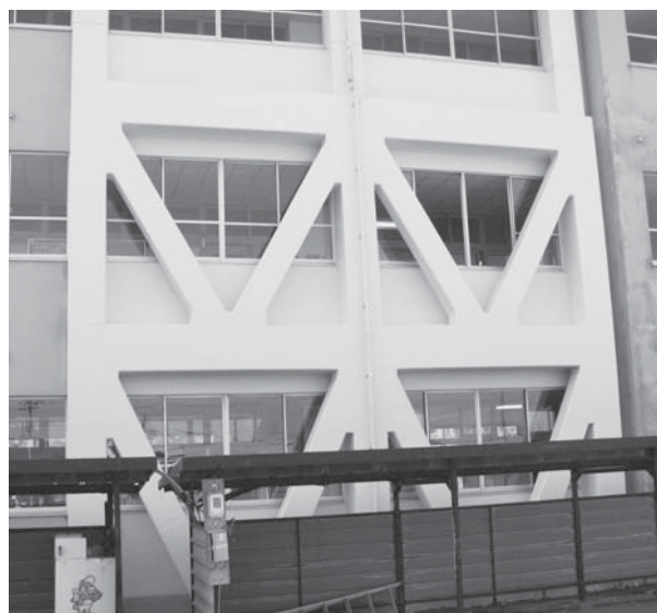
耐震化工事終了 平生中学校
