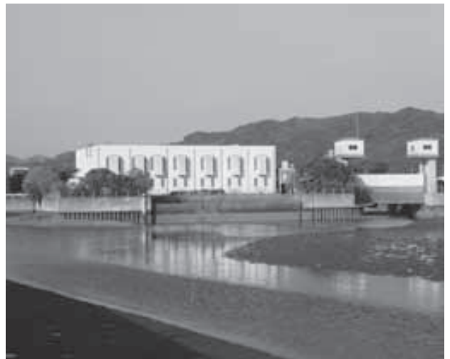
大内川排水機場
