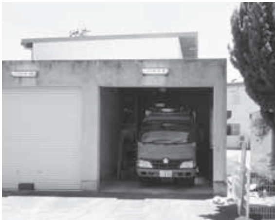
本部消防機庫
