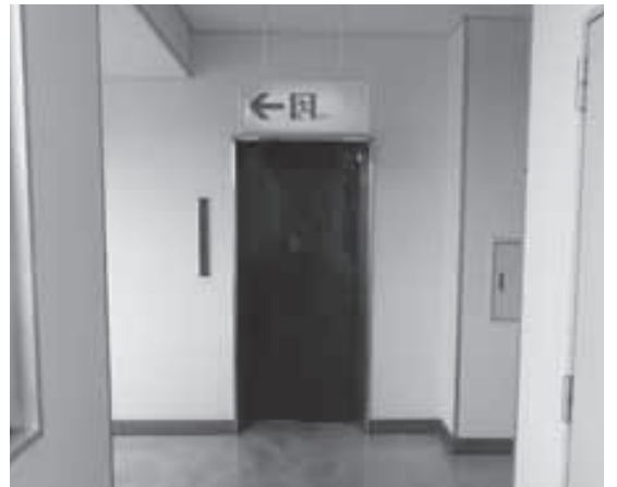
第3庁舎エレベーター
