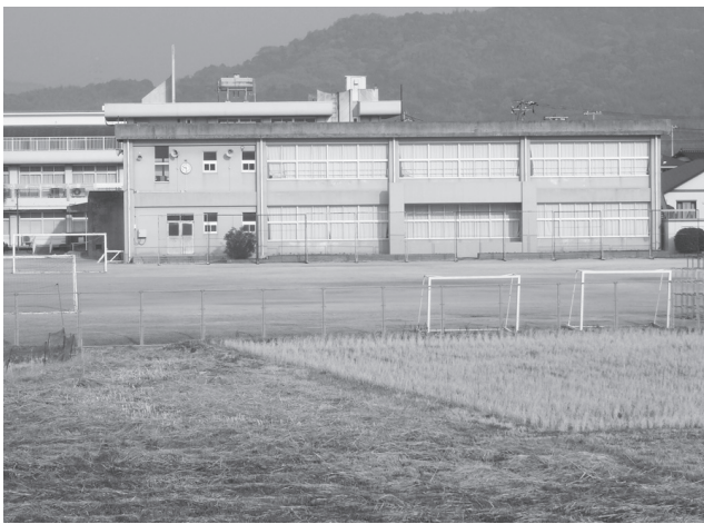
耐震化工事が完了した平生小学校の校舍
