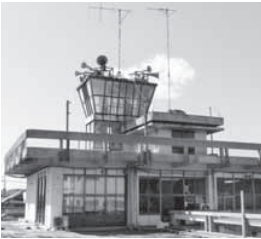
耐震強度のない役場庁舎
