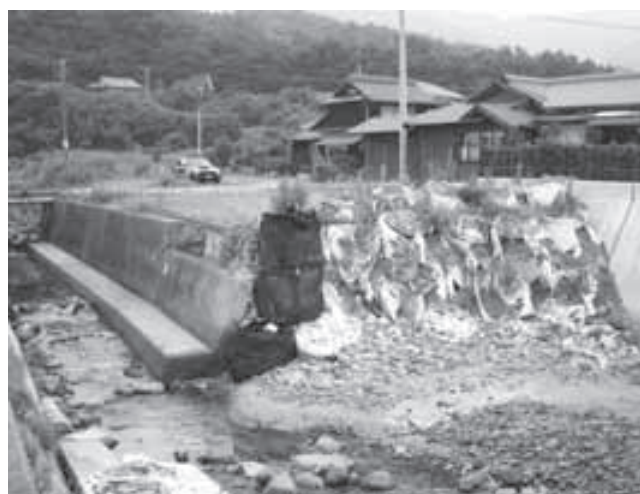
周防高潮対策事業 佐賀（荒木川）
