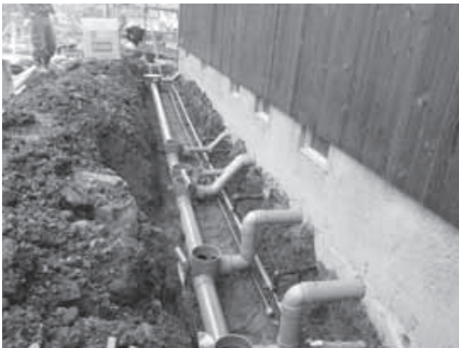
排水設備の設置工事
