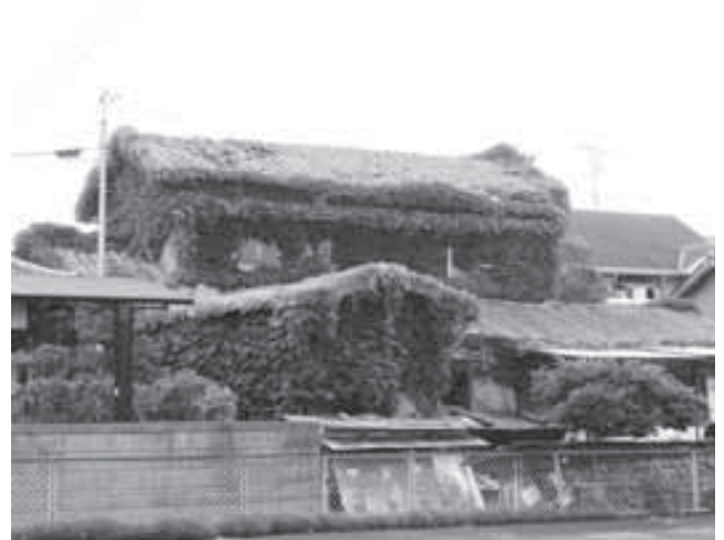
崩れかけた空き家
