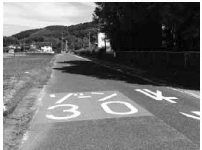
平生中付近に設定されたゾーン30
