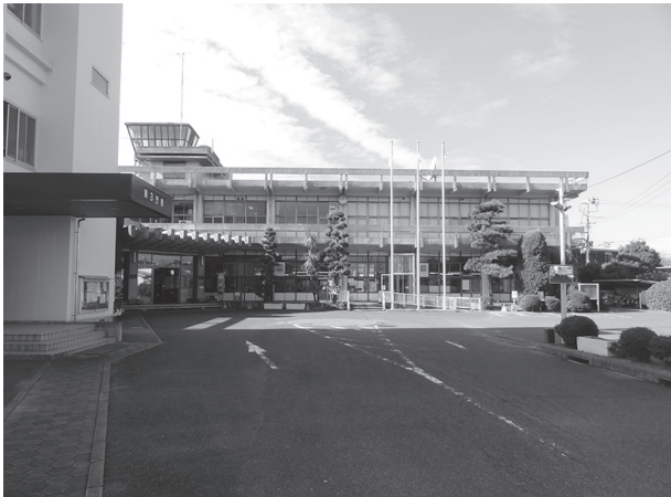
昭和35年に建てられた庁舎
