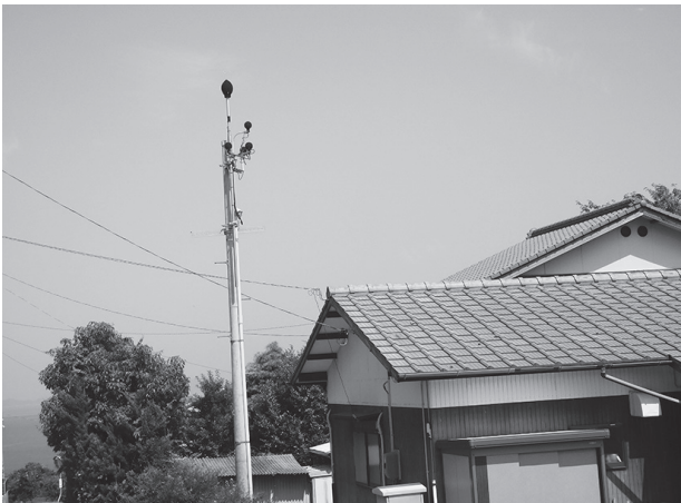
大島に設置されている騒音測定器
