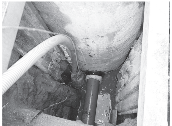
工事中の下水道
