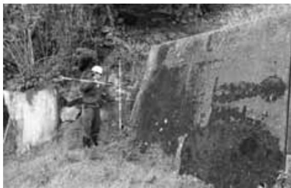
砂防ダム点検中
