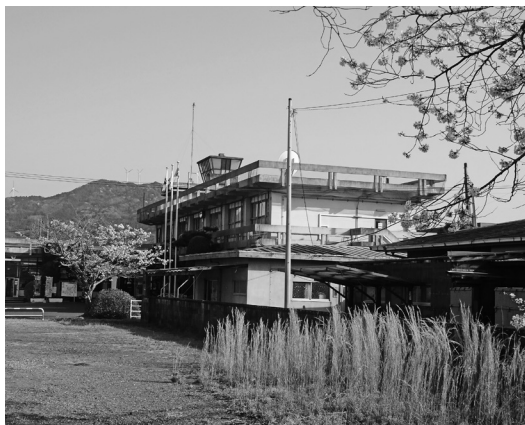
老朽化した庁舎
