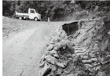
農道小郡畑線道路災害復旧工事
