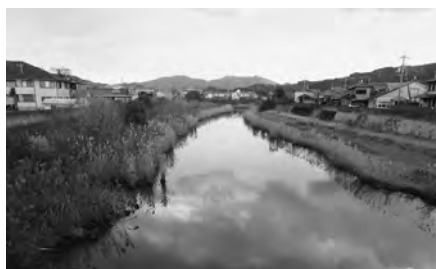
大内川排水機場の内側
