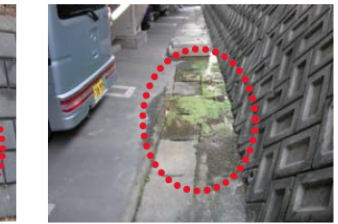
水がしみだしている擁壁 湧水部分にコケが生えている擁壁 (提供：社団法人 全国宅地擁壁技術協会)
