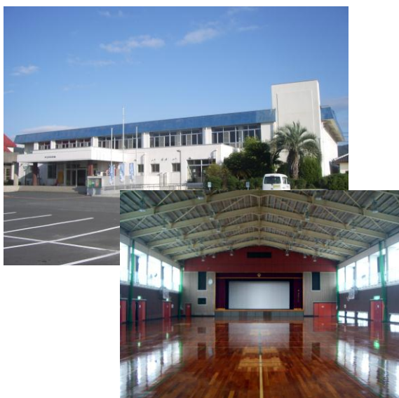
平生町体育館
