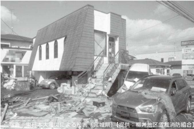
写真：東日本大震災による被害（宮城県）【提供：柳井地区広域消防組合】
