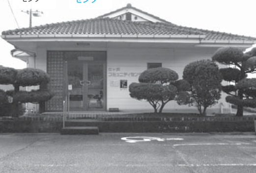
堅ヶ浜 コミュニティ センター ▶ 堅ヶ浜 地域交流 センター
