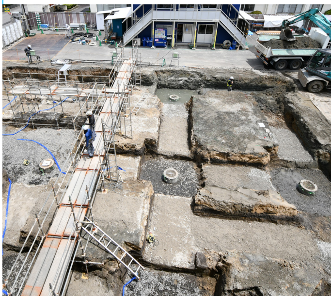
掘削工事を行いました。 (5月28日撮影)
