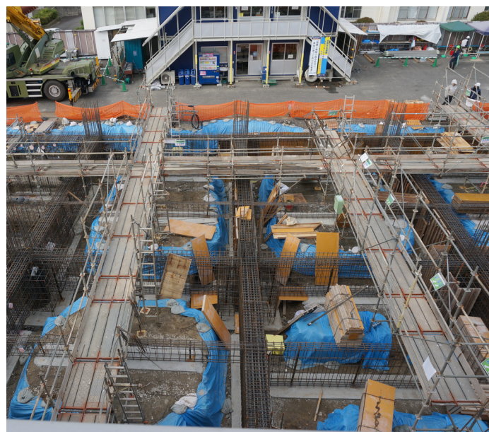
基礎配筋工事を行いました。 (6月14日撮影)
