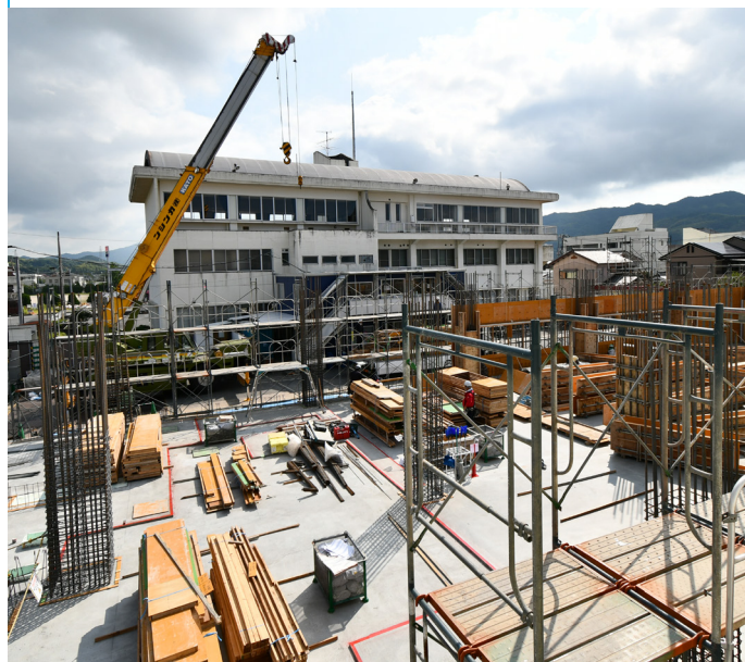
1階柱壁の配筋工事を行いました。 (7月29日撮影)
