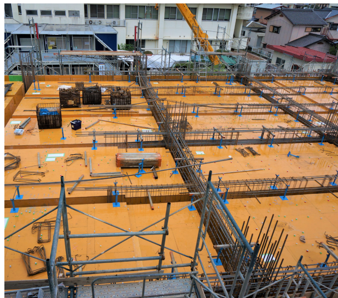
2階床の型枠工事を行いました。 (8月17日撮影)
