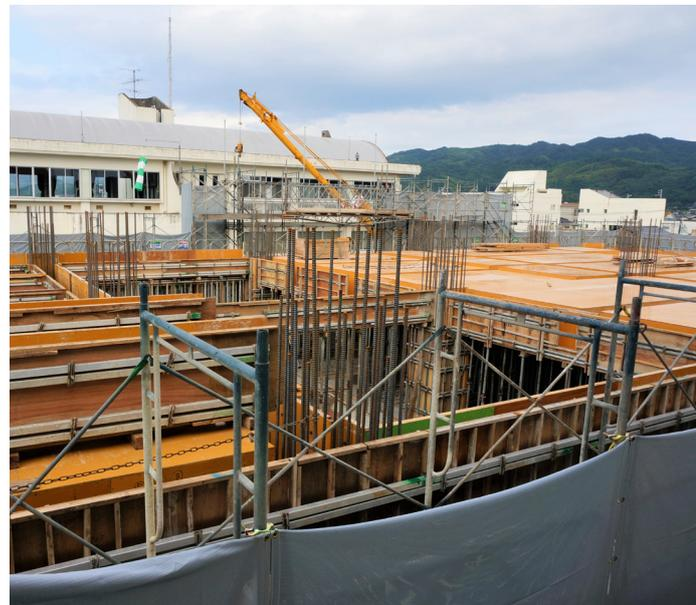
2階柱壁と3階床の型枠工事を行
