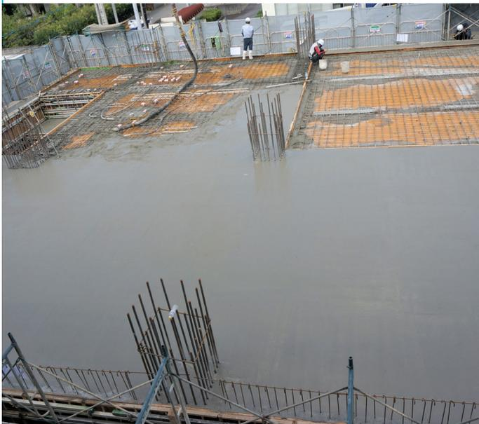
1階柱壁と2階床のコンクリート
