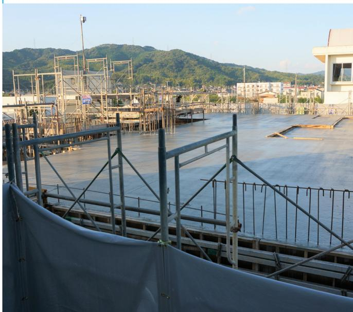
2階柱壁と3階床のコンクリート打設
