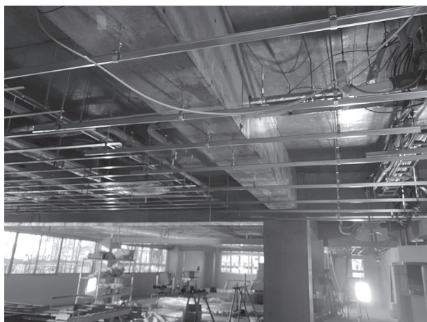
1階天井配管等工事を行いました。 10月27日撮影
