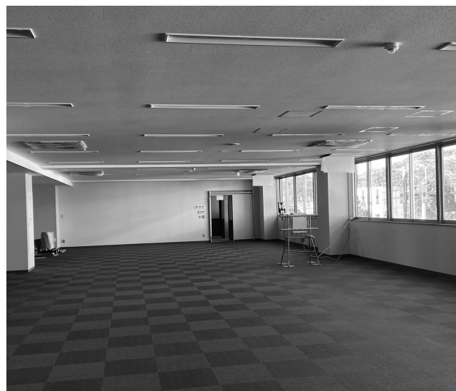
カーペットの敷き込みを行いました。2月9日撮影
