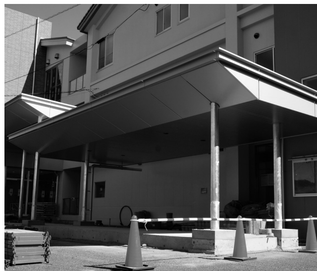
玄関前に庇（ひさし）を設置しました。2月16日撮影
