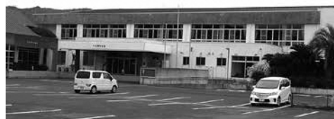
屋根・外装改修工事が予定されている体育館
