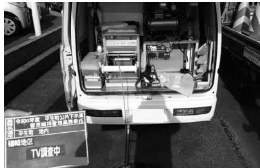
下水管の点検の様子
