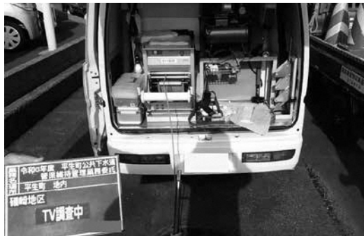
下水管の点検の様子
