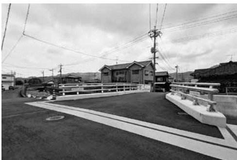
改修された共栄橋
