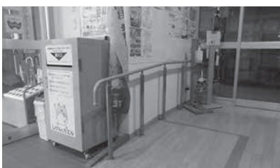
曽根地域交流センター入口に設置してある手すり
