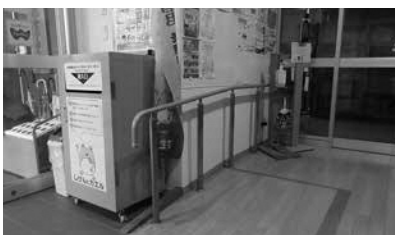
曾根地域交流センター入口に設置してある手すり
