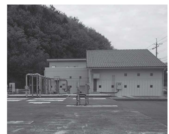
漁業集落排水処理場
