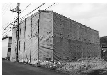
アスベストを含む家屋の解体工事
