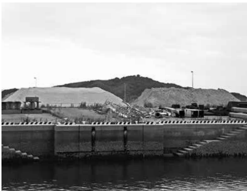
田名ふ頭 野積みの状況
