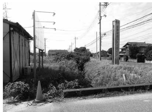
崩れている室津半島スカイライン入口看板付近
