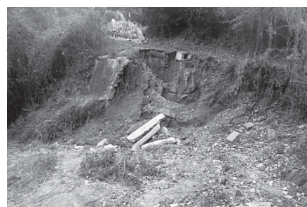
豪雨災害被災箇所（大野北 喜多）
