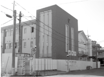
建設中の新庁舎
