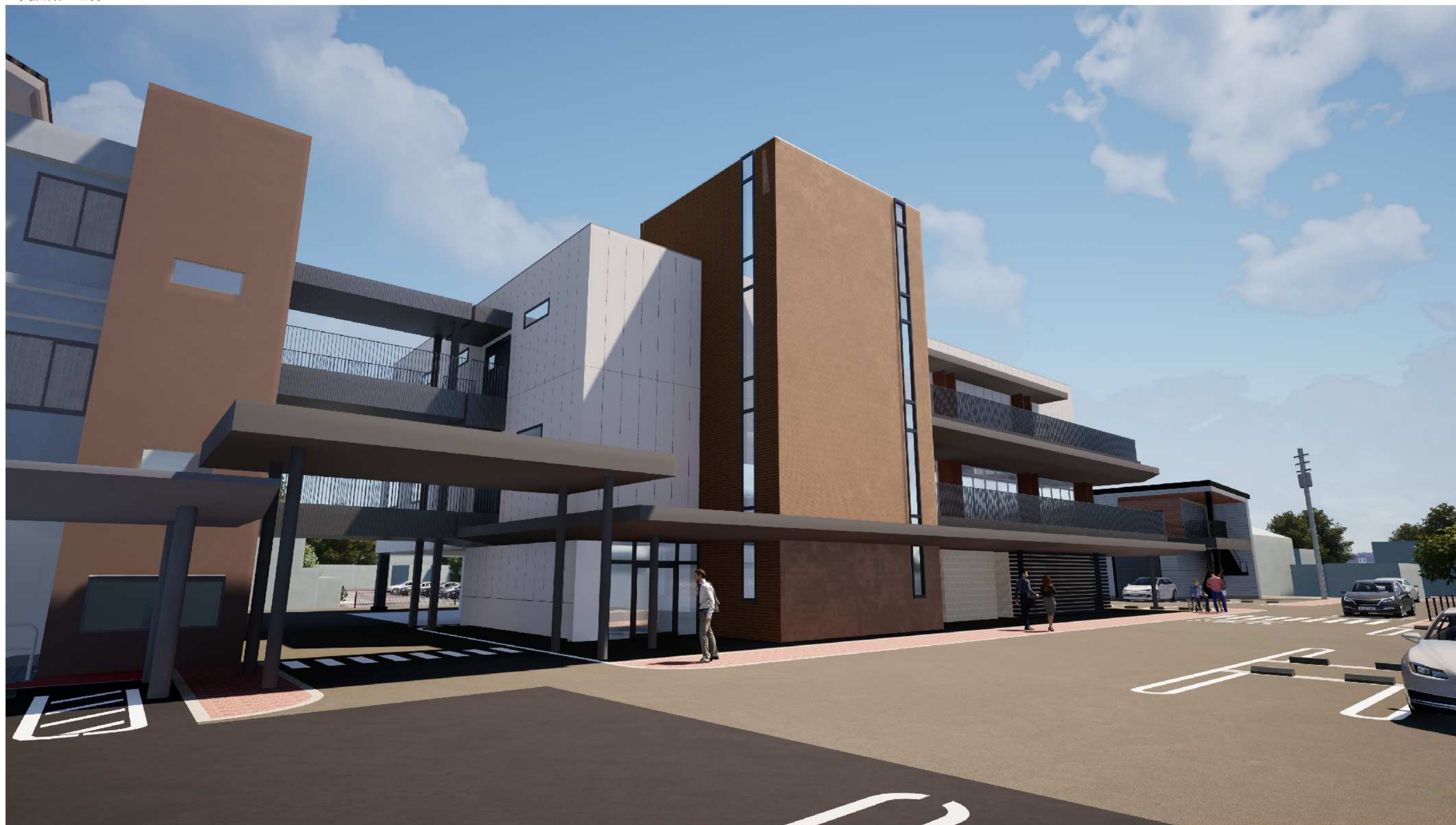
■事務所棟 北側
