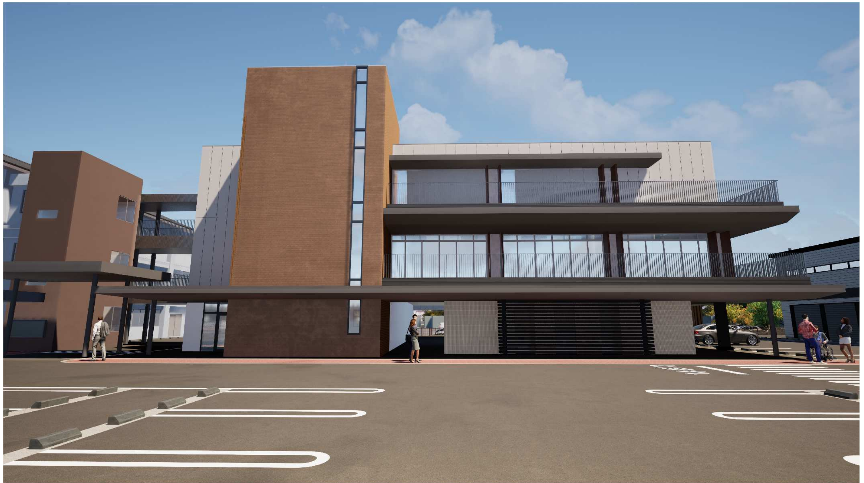
■事務所棟 正面
